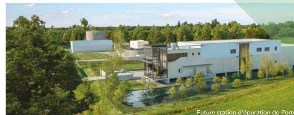
Future station d'épuration de Porto
