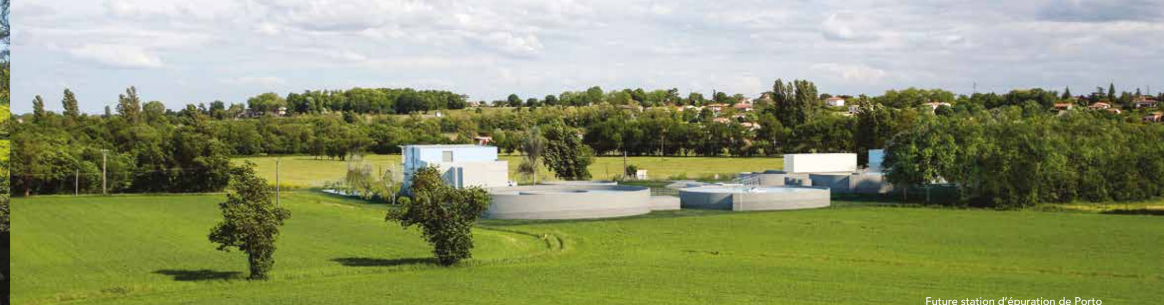
Future station d'épuration de Porto
