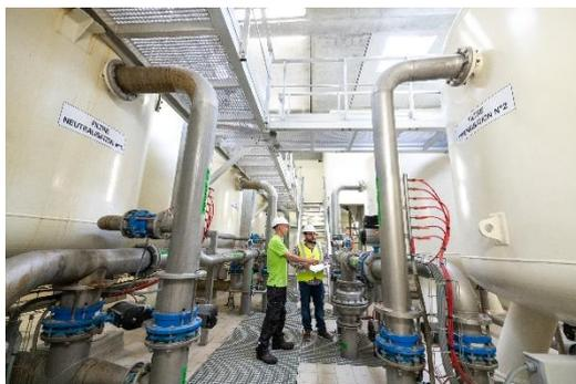
L'eau du forage est déferrisée puis un traitement sur 3 filtres fermés à neutralite permet de remonter et maintenir le pH à l'équilibre.
