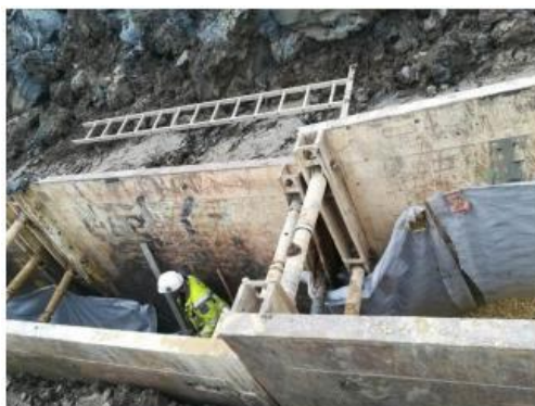
Photos des travaux de pose de la canalisation de rejet de la STEP de PORTO
