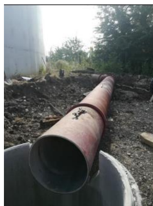
Photos des travaux de pose de la canalisation de rejet de la STEP de PORTO
