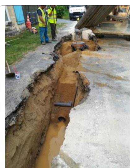
Photos des travaux de pose du réseau d'eaux usées sur la commune de LA LANDE DE FRONSAC
