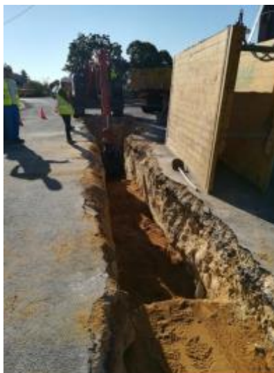
Photos des travaux de pose du réseau d'eaux usées sur la commune de LA LANDE DE FRONSAC
