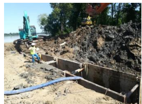
Photos des travaux de pose de la canalisation de rejet de la STEP de PORTO
