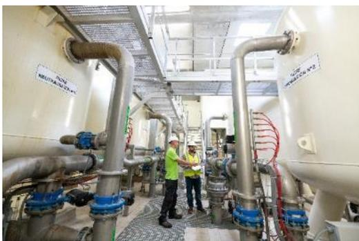
L’eau du forage est déferrisée puis un traitement sur 3 filtres fermés à neutralité permet de remonter et maintenir le pH à l’équilibre.
