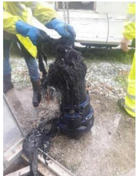
Nous vous proposons d’installer un dégrilleur en entrée du poste afin de protéger les pompes. Cet équipement permettra aussi de réduire la quantité de déchet transféré vers le prétraitement de la station de Porto.
