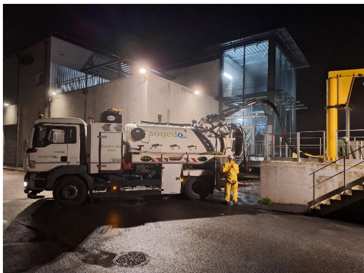
Nettoyage du poste de relevage d'entrée de la STEP de Porto
